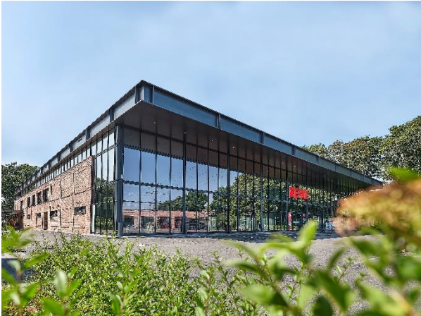
[Stelling Hoefe_heroal C 50_Glasfassade]
