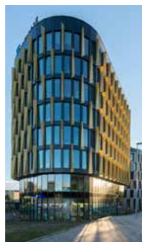
Kotelna Park II, Prag, Tschechien BREEAM „Very good“ zertifiziert
