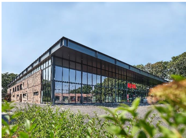
[Stelling Höfe_heroal C 50_Glasfassade]
