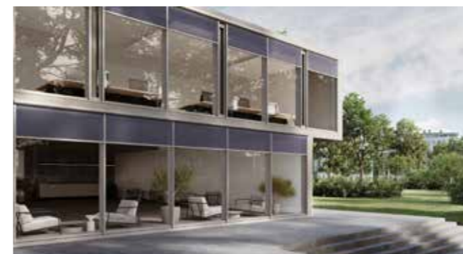
Montáž na fasádu
